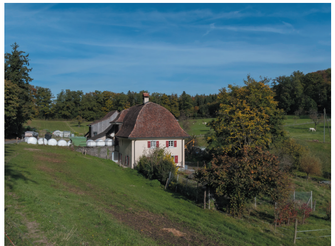
Blick auf die Südfassade der Ränggersmatt. Foto H. Leuthardt
